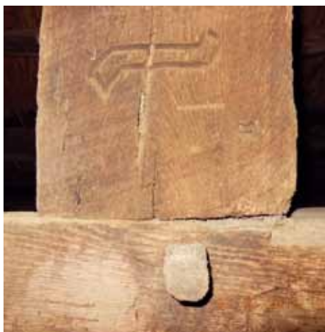
Gotisk tømmermærke og savspor.
