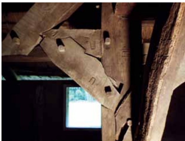
Tømmersamling i Vinkelgården med krumme skråbånd og såkaldt hagebladning, hvor en slags modhager forhindrer samlingen i at skride fra hinanden.
